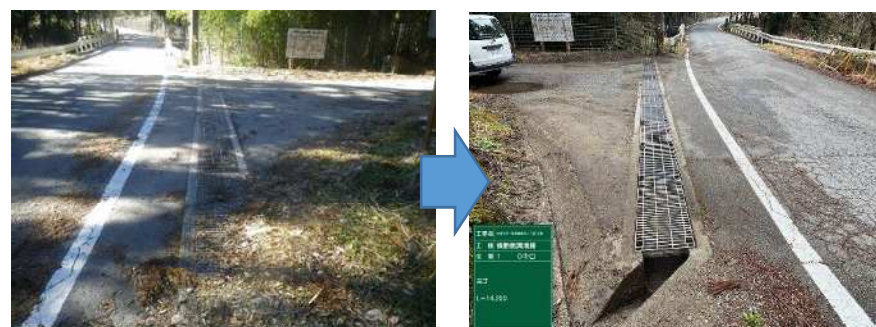
横断溝清掃工 施工前
