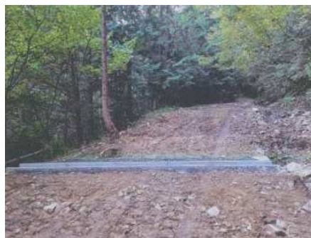
【作業道改良事業】横断工設置
