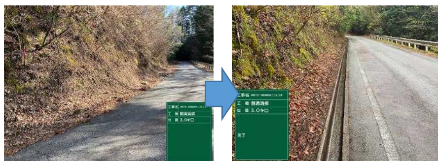
側溝清掃工 施工前
