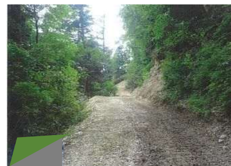
【作業道維持補修事業】 崩土除去 実施後 (御厩野)
