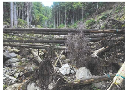
箇所② 施業前（小坂町）
