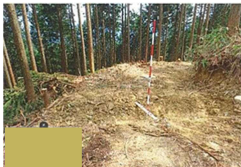
【森林作業道開設】 排水処理設置 (御厩野)
