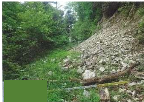
【作業道維持補修事業】 実施前 (御厩野)
