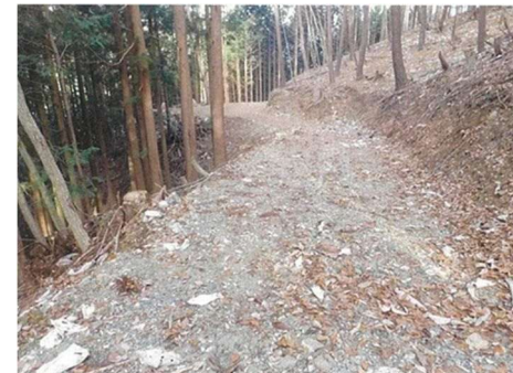
【森林作業道開設】 実施後 (萩原町尾崎)
