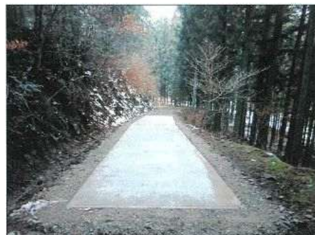
【作業道改良性事業】 コンクリート舗装設置 (萩原町尾崎)
