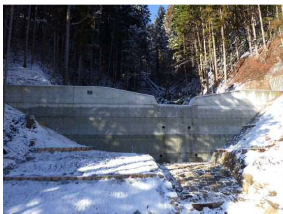
治山事業 堰堤
