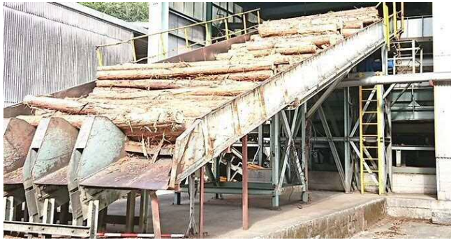
①原料（C・D材）の投入口
