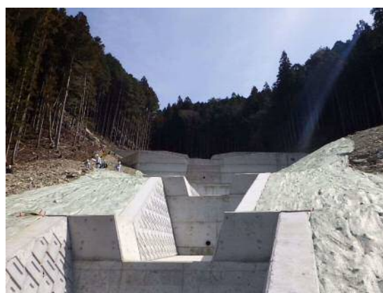
治山事業 流路工
