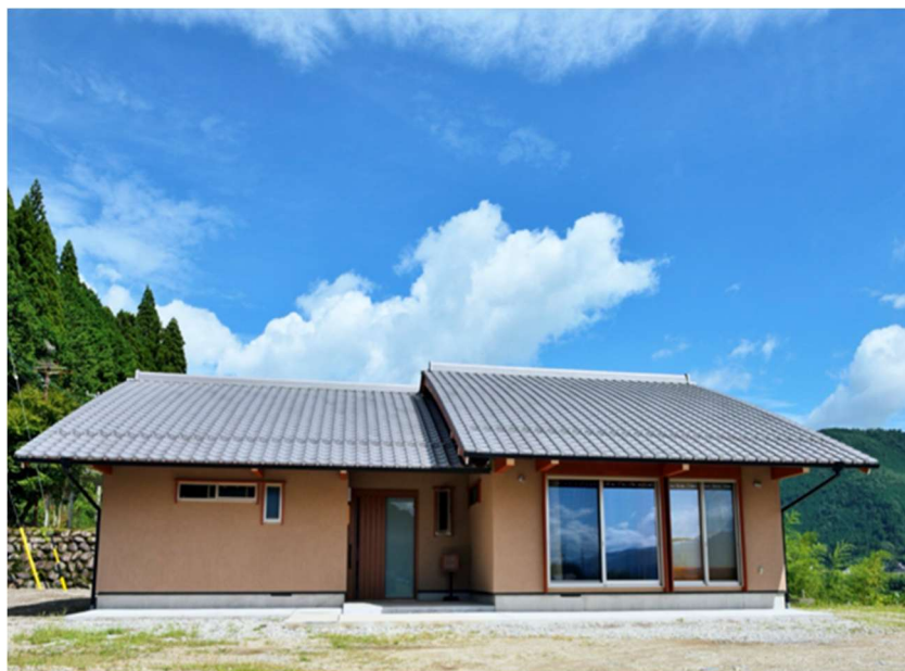
【建築物部門】 空工舎合同会社 住宅兼建築事務所
