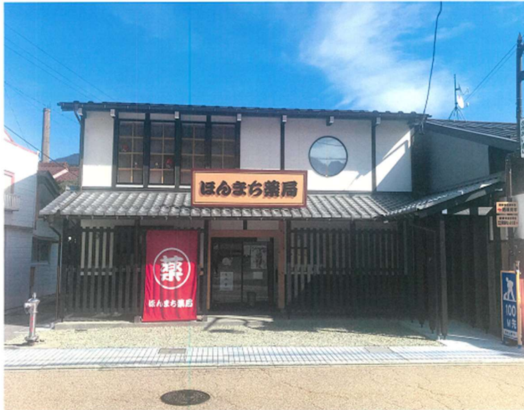
【建築物の部】ユニファーマシーほんまち薬局
