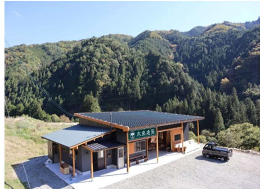
【建築物部門】(株)木楽建築の工場兼事務所
