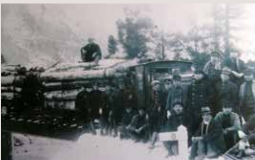
▲木材を搬出していた小坂の森林鉄道
