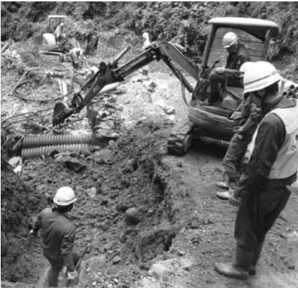
▲水道の復旧に向けて作業する工事 事業者＝馬瀬西村
