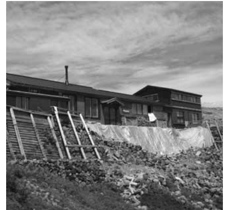
▲応急復旧後の五の池小屋 ＝小坂町落合
