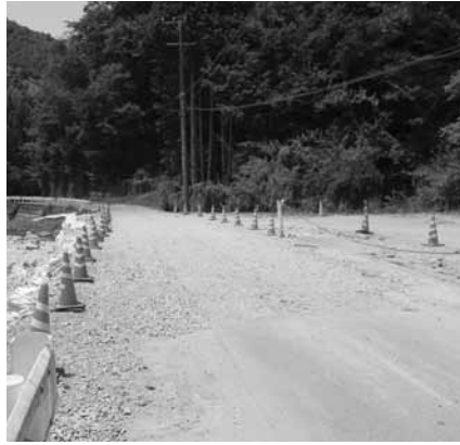
▲陥没した道路の応急復旧後 ＝久野川、市道中原西3号線
