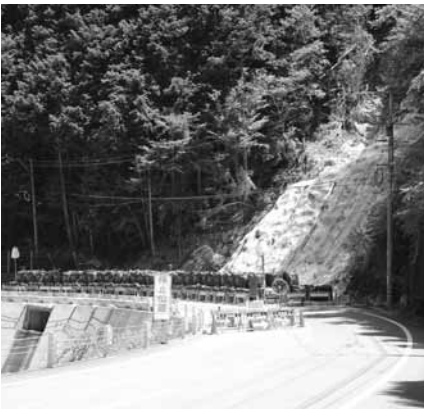
▲土砂崩れにより塞がれた道路の応急 復旧後＝夏焼、県道下呂白川線
