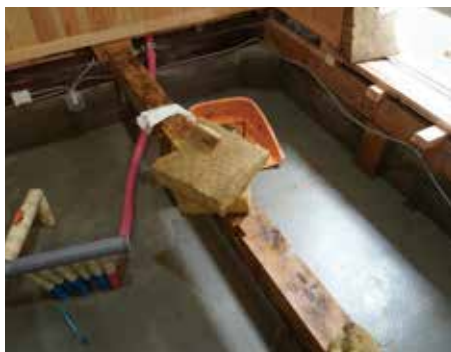
▲床下の掃除が完了
