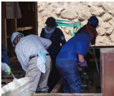
▲浸水した部屋の床下を掃除中
