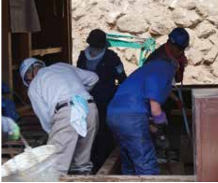
▲浸水した部屋の床下を掃除中
